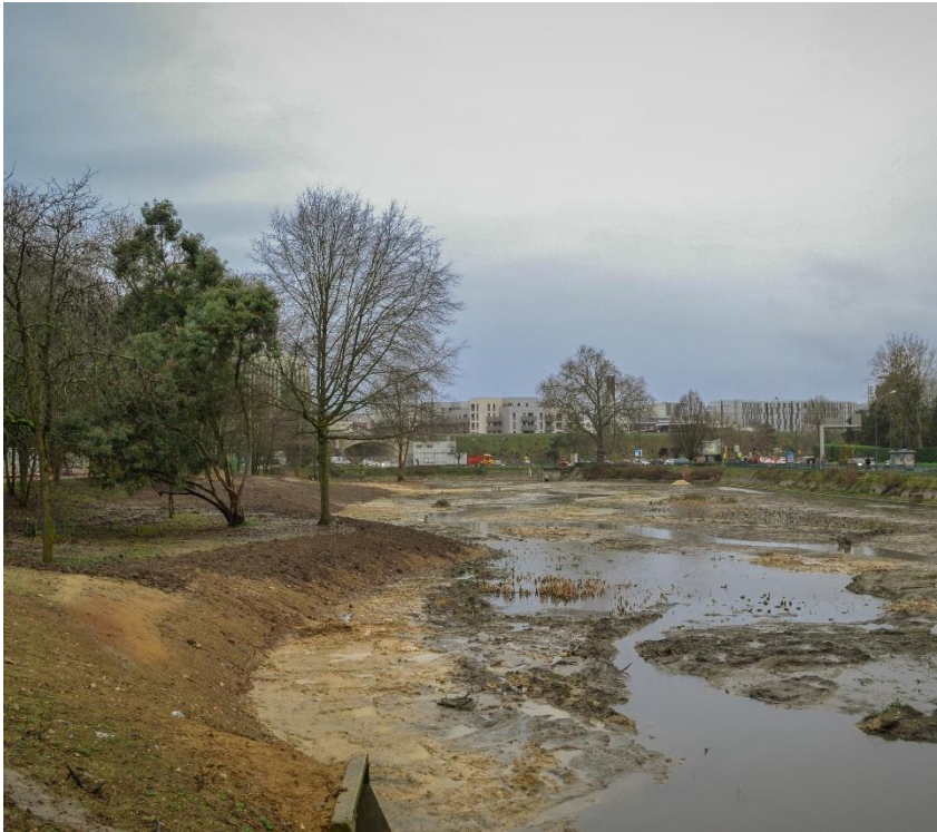
Restauration écologique du Ru des Gains dans le bassin du bois des Briis, Massy. ©Soline Zerbini--Boussard
